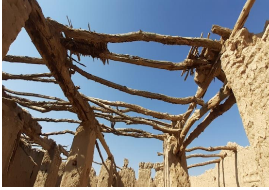
صورة توضح سقف بيت الصلاة
