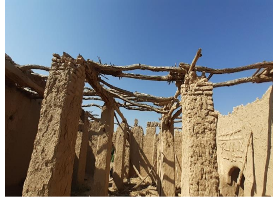
صورة توضح سقف بيت الصلاة
